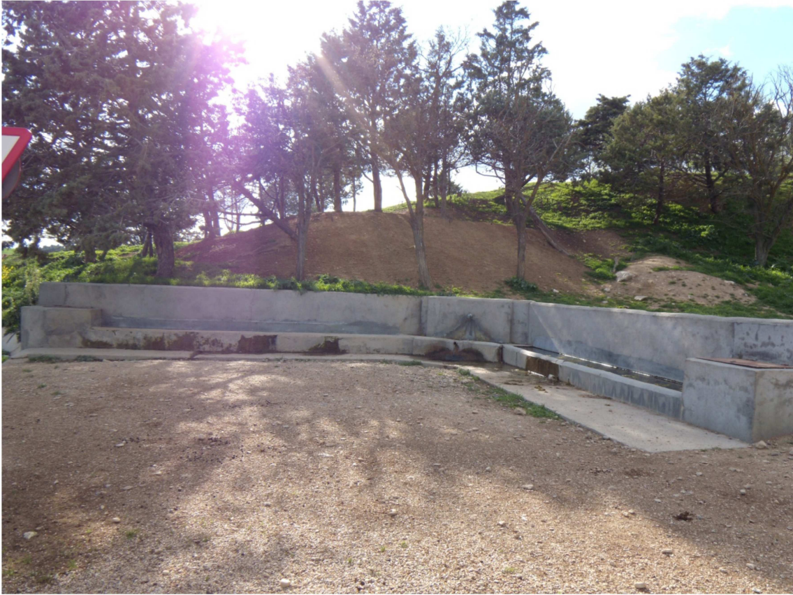
Torrelobatón, comarca de los Montes Torozos (Valladolid) Abrevadero nuevo
